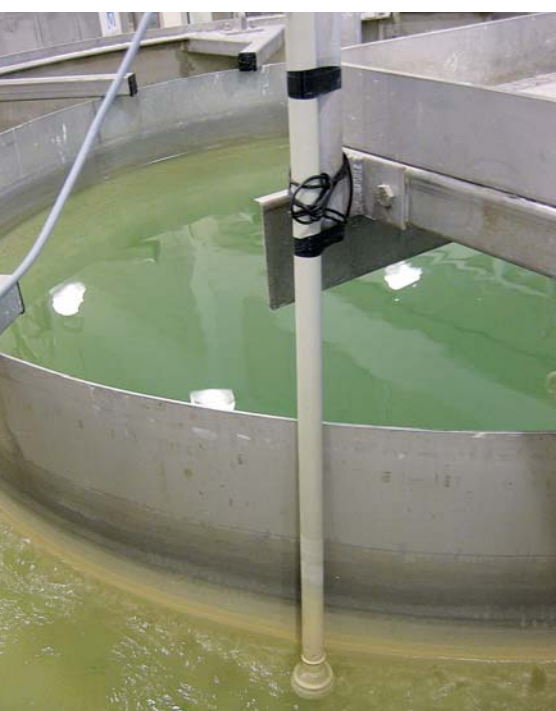
REAKTORÜBERLAUF: Einbau der Leitfähigkeitsmessung
